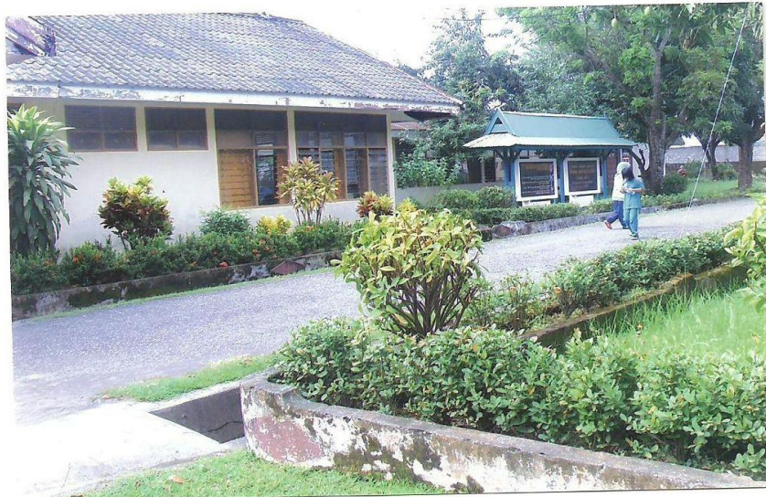
Gambar 7. Tampak dari Samping Sekolah Sentra PK-PLK SLB Negeri Pembina Provinsi Sulawesi-Selatan (Foto: Atira Muchtar 2010)
