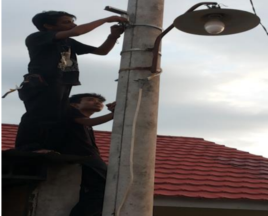
Gambar 51 b. Pemasangan Braket CCTV pada Tiang Listrik
