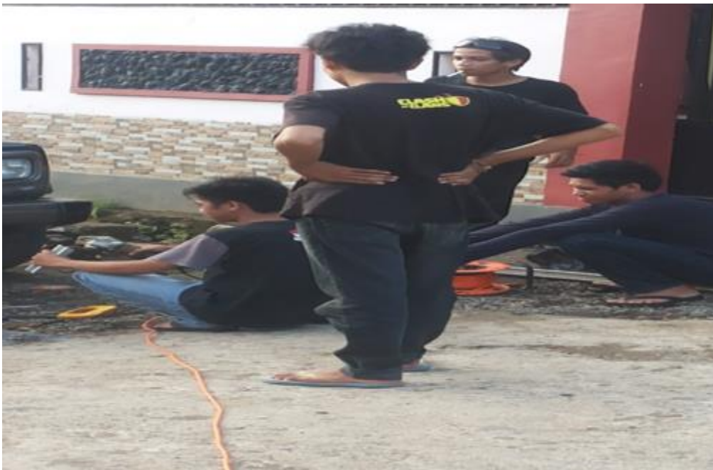
Gambar 51 a. Merakit Braket CCTV Untuk Tiang Listrik
