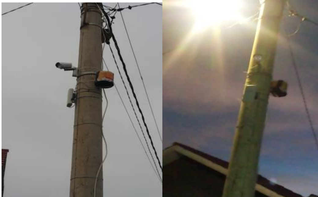
Gambar 54 a. Instalasi CCTV 2 oleh petugas PLN
