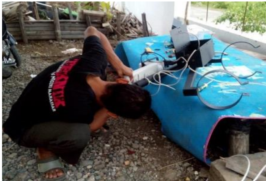
Gambar 4.33 Merakit CCTV dan Wireless Outdoor pada Braket
