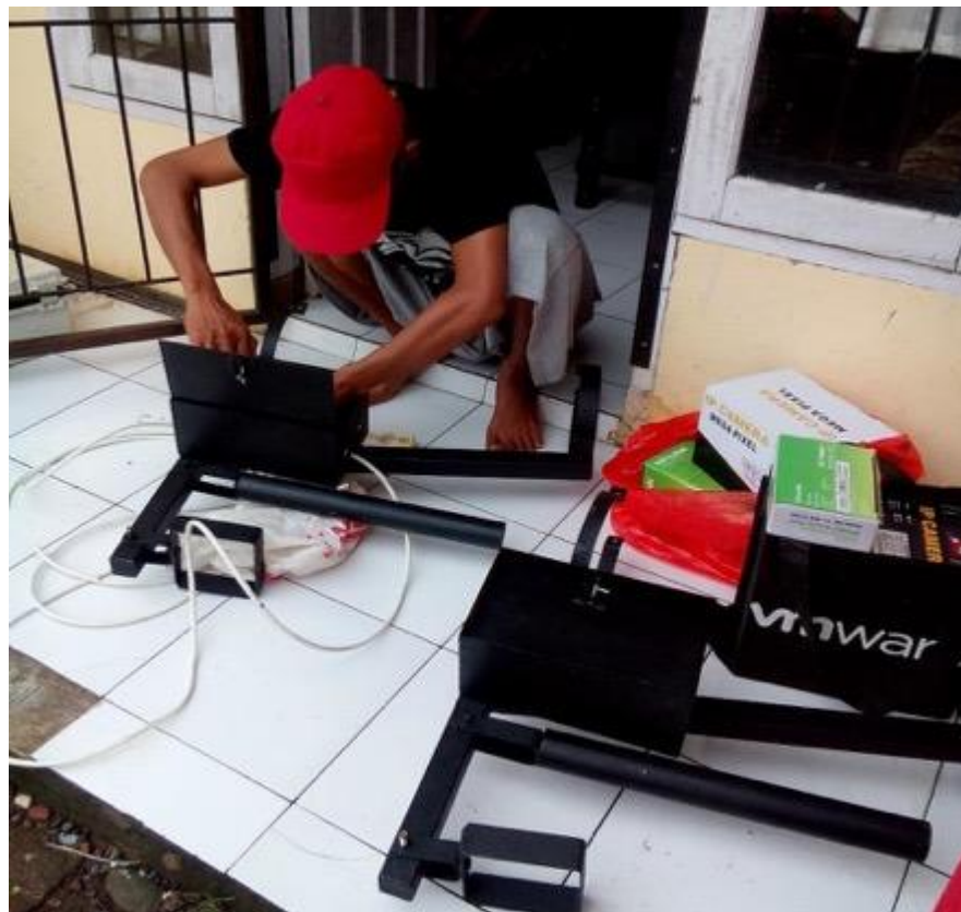
Gambar 4.32 Merakit Braket CCTV untuk tiang listrik
