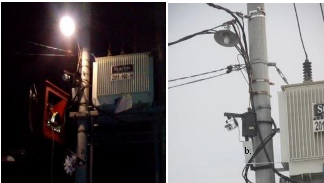
Gambar 4.34a Instalasi CCTV 1 oleh petugas Lampu Jalan PLN
