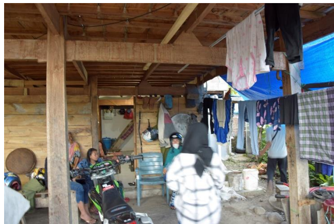
Figure 8 : kolong rumah pada bagian lontang pertama, penambahan ruang dimulai dari dibawa lontang kedua
