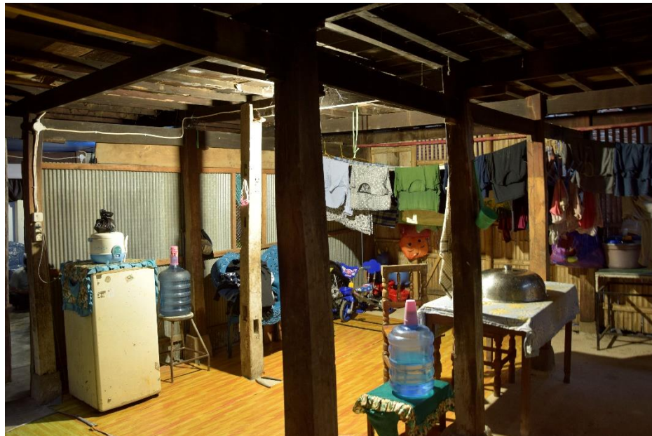
Figure 18: penambahan ruang dan fungsi baru pada kolong rumah
