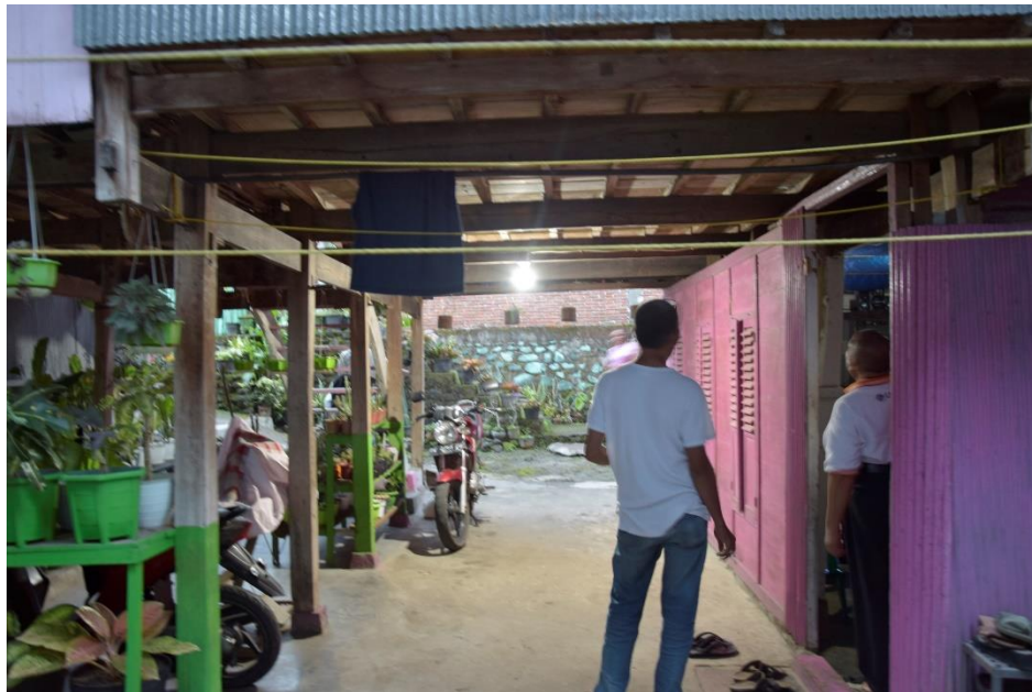
Figure 17: Perubahan pada kolong rumah
