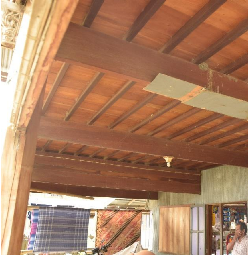
Figure 24 : T3 Sistem konstruksi pada lantai rumah Sumber : Andi Abidah & Taufiq Natsir 2021
