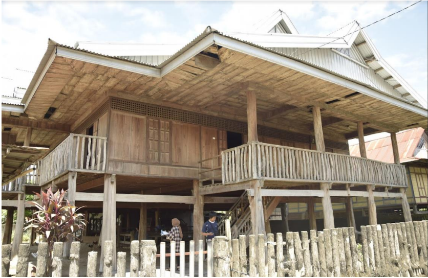
Figure 51 : T8 sisi kiri bagian rumah, Sumber : Andi Abidah & Taufiq Natsir 2021
