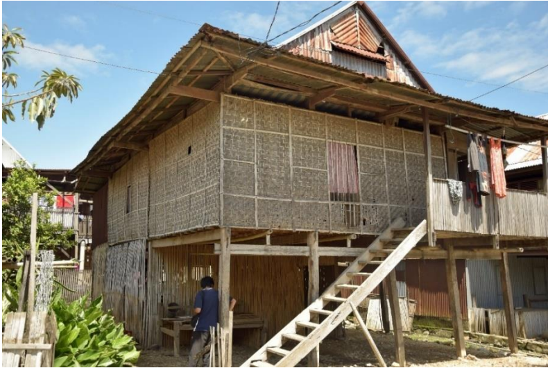
Figure 66 : T10 sisi kiri bagian rumah Sumber : Andi Abidah & Taufiq Natsir 2021
