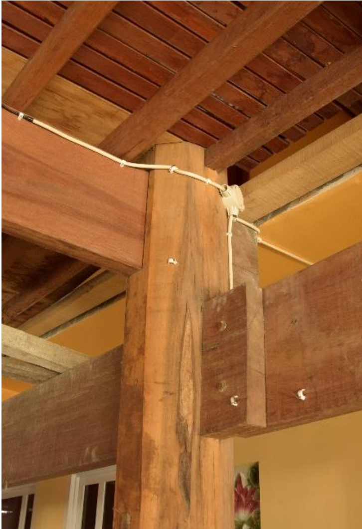
Figure 10 T1 : sambungan antara indobola dan anabola. Sumber : Foto Andi Abidah & Taufiq Natsir, 2021
