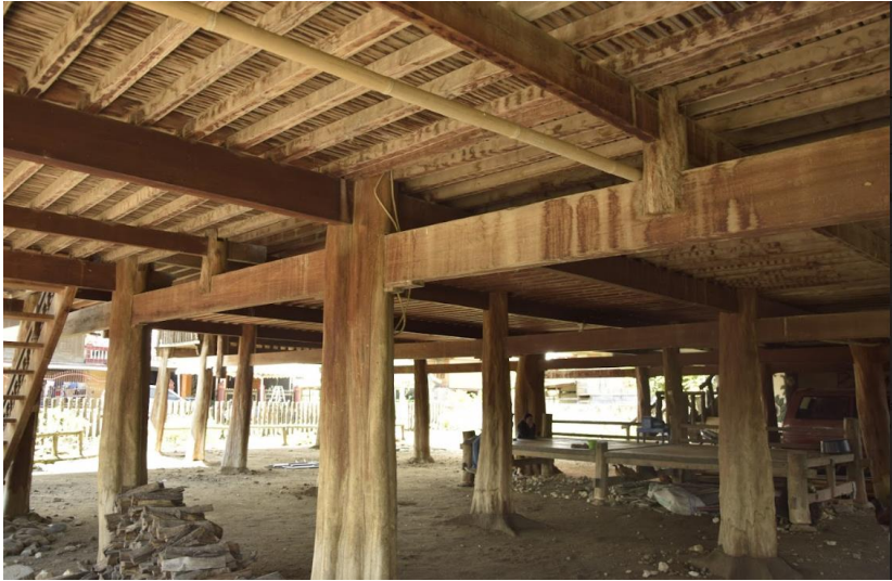
Figure 53 : T8 Sistem konstruksi pada lantai rumah Sumber : Photograprer Andi Abidah & Taufiq Natsir
