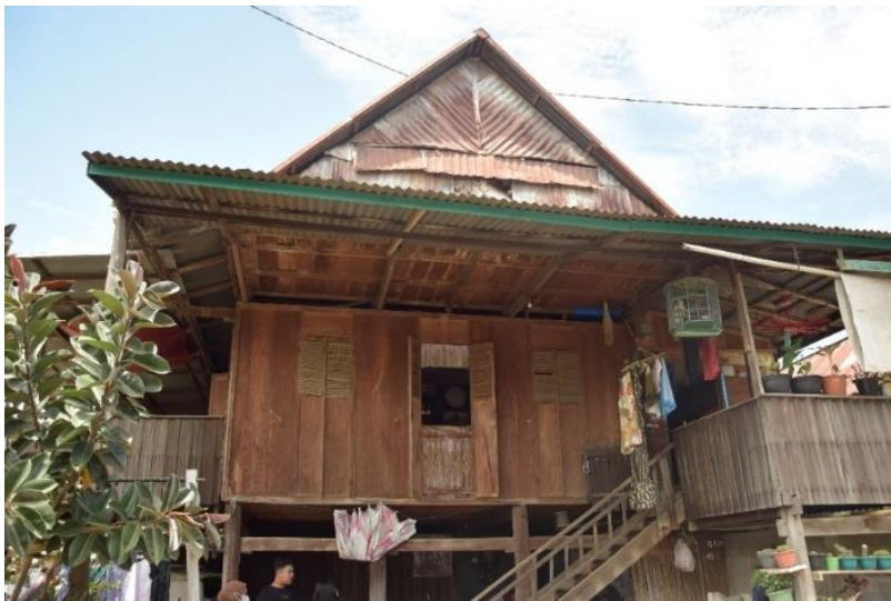
Figure 38: T6 Rumah Bugis Tolotang, atap tangga dan lego-lego menyatu., Sumber : Andi Abidah & Taufik Natsir, 2021
