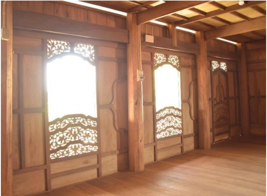
Figure 9 : T1 letang jendela berada diantara tiang rumah dan dinding berada di depan tiang rumah Sumber : Andi Abidah & Taufiq Natsir 2021
