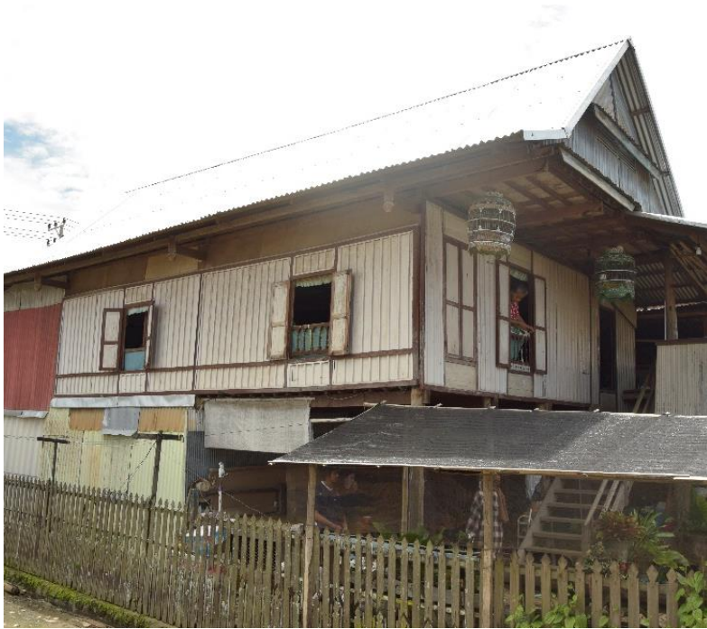
Figure 28 : T4 Sisi kiri bagian rumah, Sumber : Andi Abidah & Taufiq Natsir 2021
