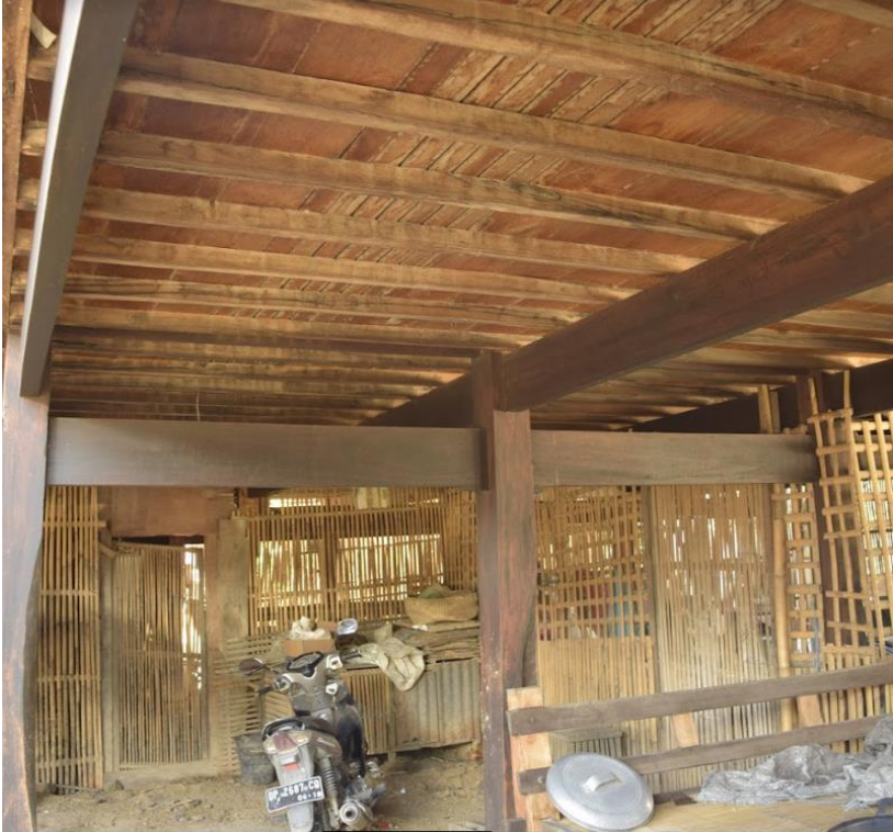
Figure 62 : T9 Sistem konstruksi pada lantai rumah Sumber : Andi Abidah & Taufiq Natsir
