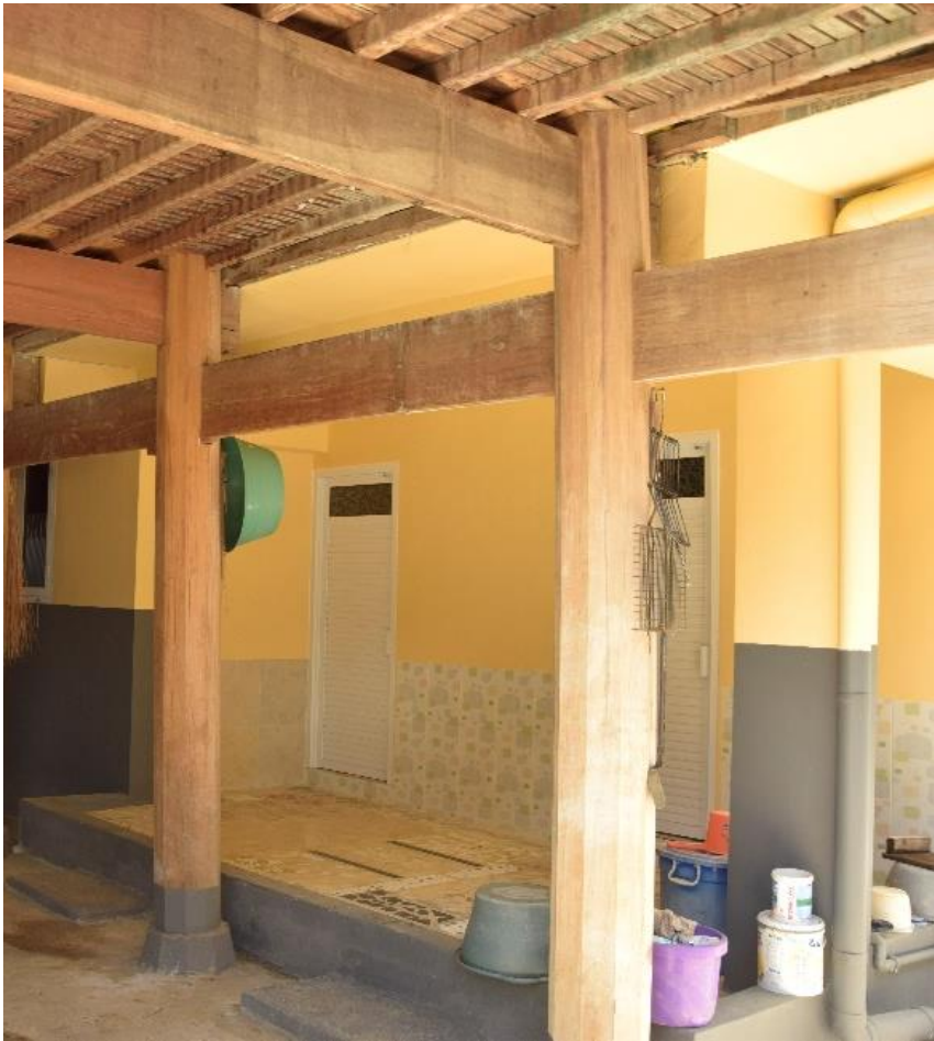
Figure 11 : T1 kamar mandi, tempat mencuci dan toilet Sumber: Foto Andi Abidah & Taufiq Natsir, 2021
