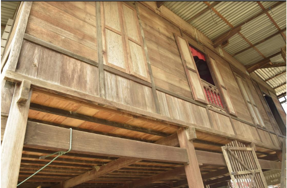
Figure 35 : T5 Sisi kiri bagian rumah, Sumber : Andi Abidah & Taufiq Natsir 2021
