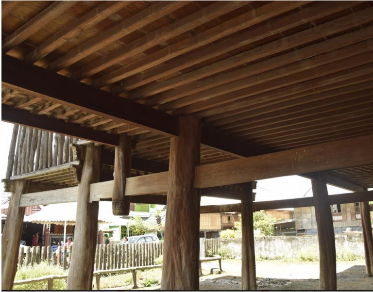
Figure 56 : T8 sambungan kayu pada bagian tangga dan lego-lego, Sumber : Andi Abidah & Taufiq Natsir
