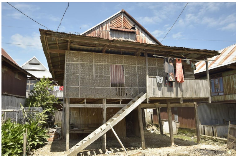
Figure 65:T10. Rumah Bugis dengan tiang berbentuk segiempat dengan material dinding dari Bambu Sumber : Andi Abidah & Taufiq Natsir 2021
