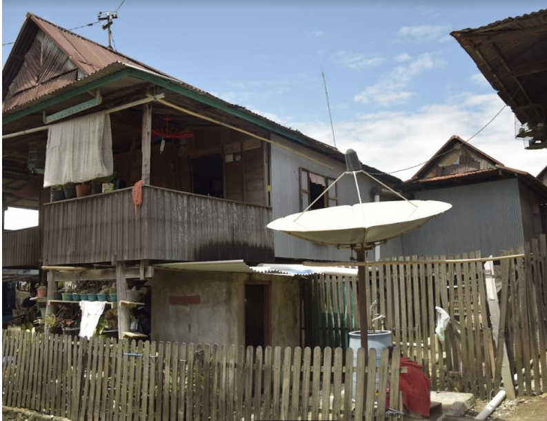
Figure 39 : T6 sisi kiri bagian rumah, Sumber : Andi Abidah & Taufiq Natsir 2021
