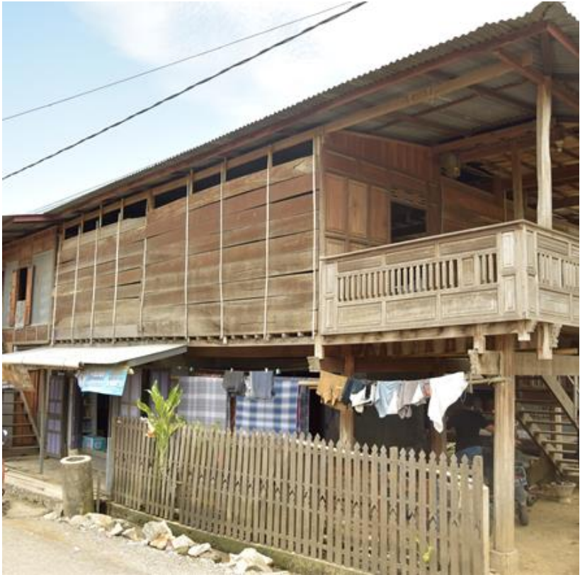
Figure 22 : T3 Sisi Kiri bagian rumah, Sumber : Andi Abidah & Taufiq Natsir, 2021
