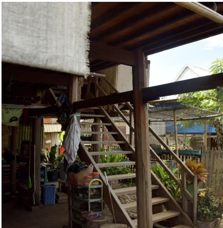
Figure 30 : T4 - Tiang kolong Rumah berbentuk bundar, Sumber: Andi Abidah & Taufiq Natsir, 2021
