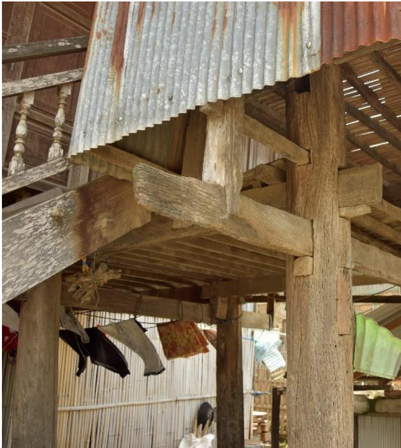
Figure 17: T2 sambungan kayu pada bagian tangga dan lego-lego, Sumber : Andi Abidah & Taufiq Natsir
