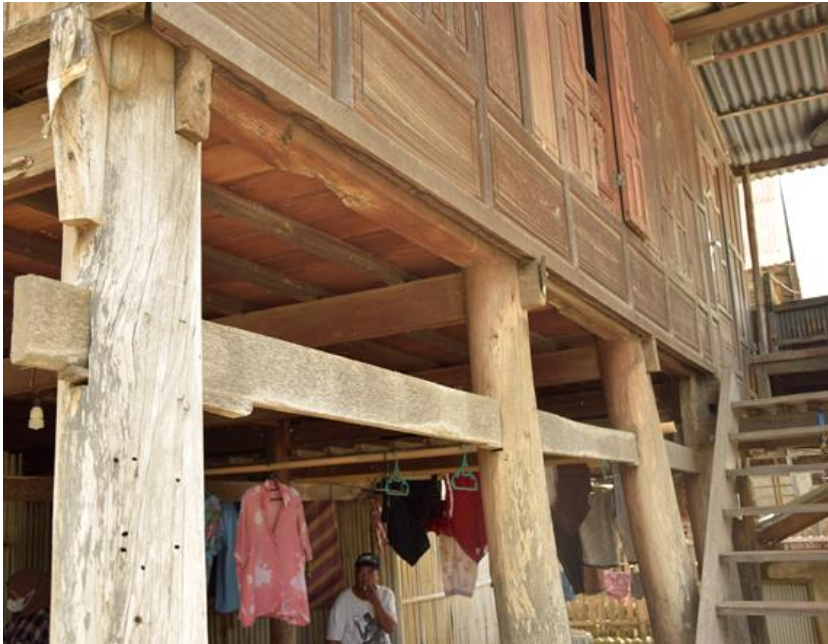
Figure 14 : T2 kolong dan tangga, tiang berukuran Bundar, Sumber : Foto Andi Abidah dan Taufiq Natsir
