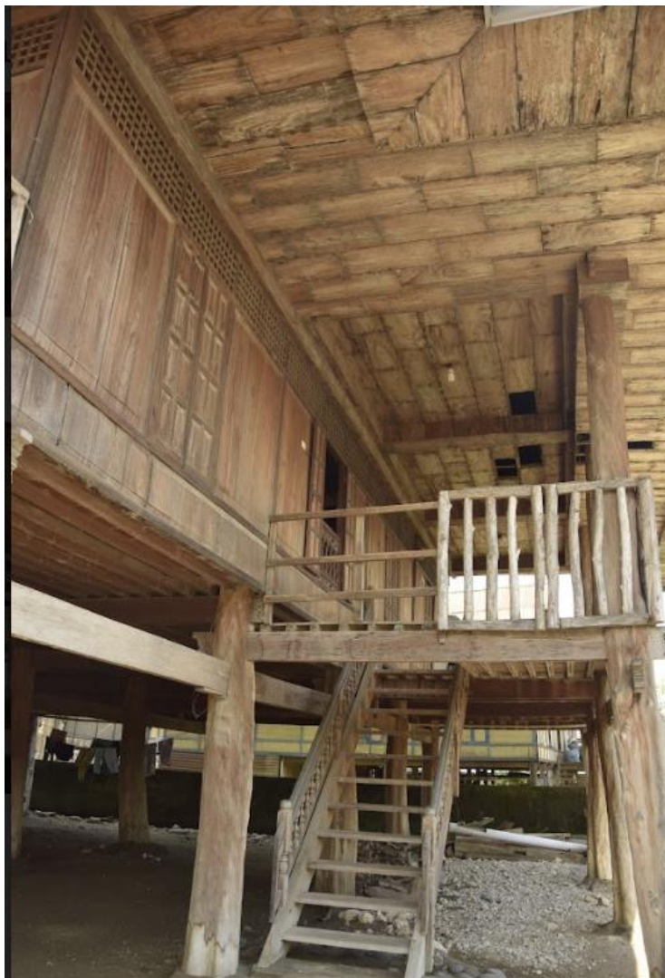
Figure 52 : T8 Tangga dan sistem konstruksi pada lego-lego, Sumber : Andi Abidah & Taufiq Natsir 2021
