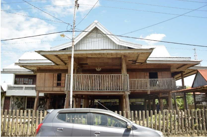
Figure 50: T8 Rumah Bugis Tolotang yang telah mengalami perubahan bentuk pada atap dan bentuk fasade. Sumber: Andi Abidag & Taufiq Natsir, 2021
