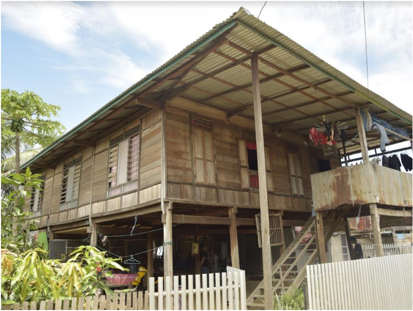
Figure 33: T5. sisi kiri bagian rumah, Sumber : Andi Abidah & Taufiq Natsir 2021
