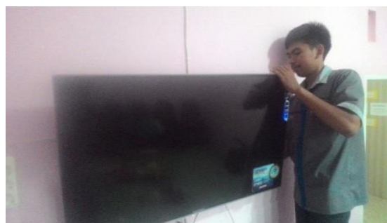
Gambar 3. Proses Pemasangan TV LCD
