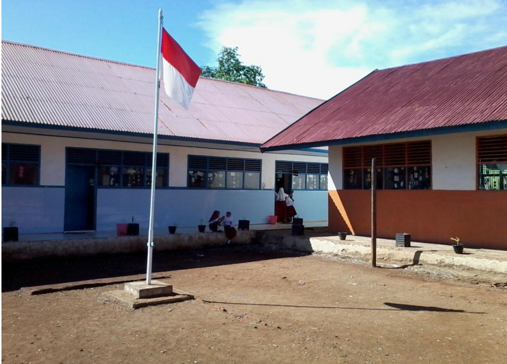
Kondisi Sekolah SDN 86 Mangarabombang
