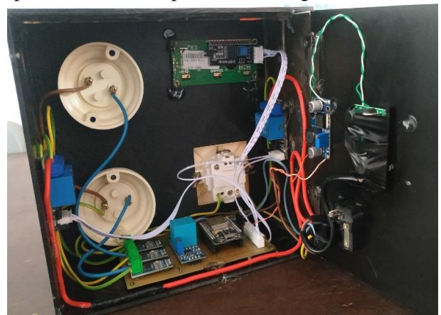
Gambar 4. Instalasi perangkat keras dalam box
