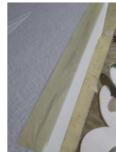
Gambar 24. merapikan sambungan styrofoam (Dokumentasi: Agung Wirawan, 2022).
