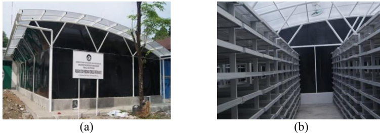
157 Gambar 1. Alat pengering tenaga surya tipe efek rumah kaca (a) bangunan alat pengering 158 (tampak luar), dan (b) rak pengering 159
