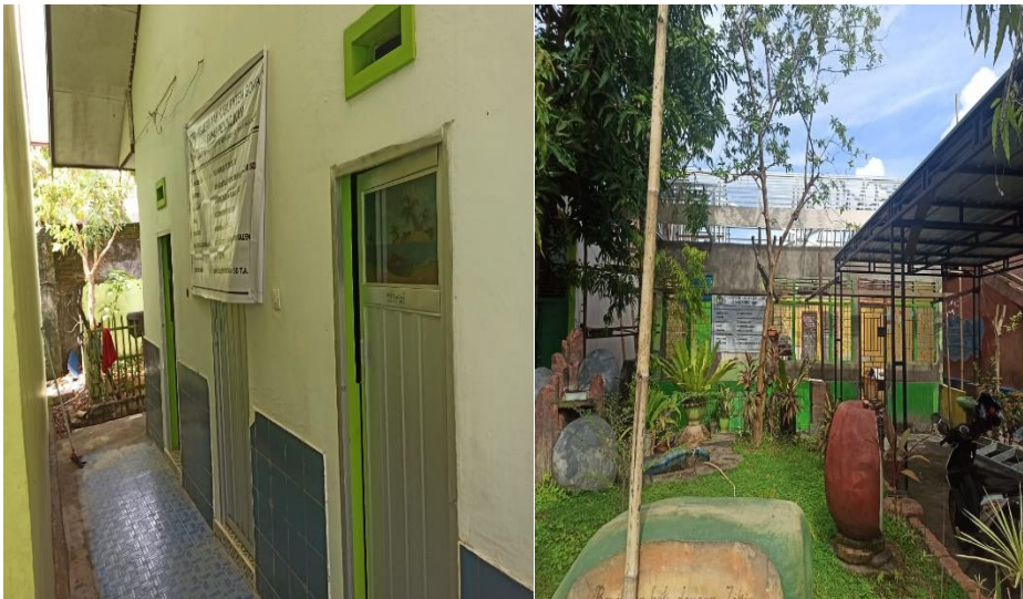
Foto 4. Ruang Guru & WC Renovasi (Pelaksanaan RKT 2020)
