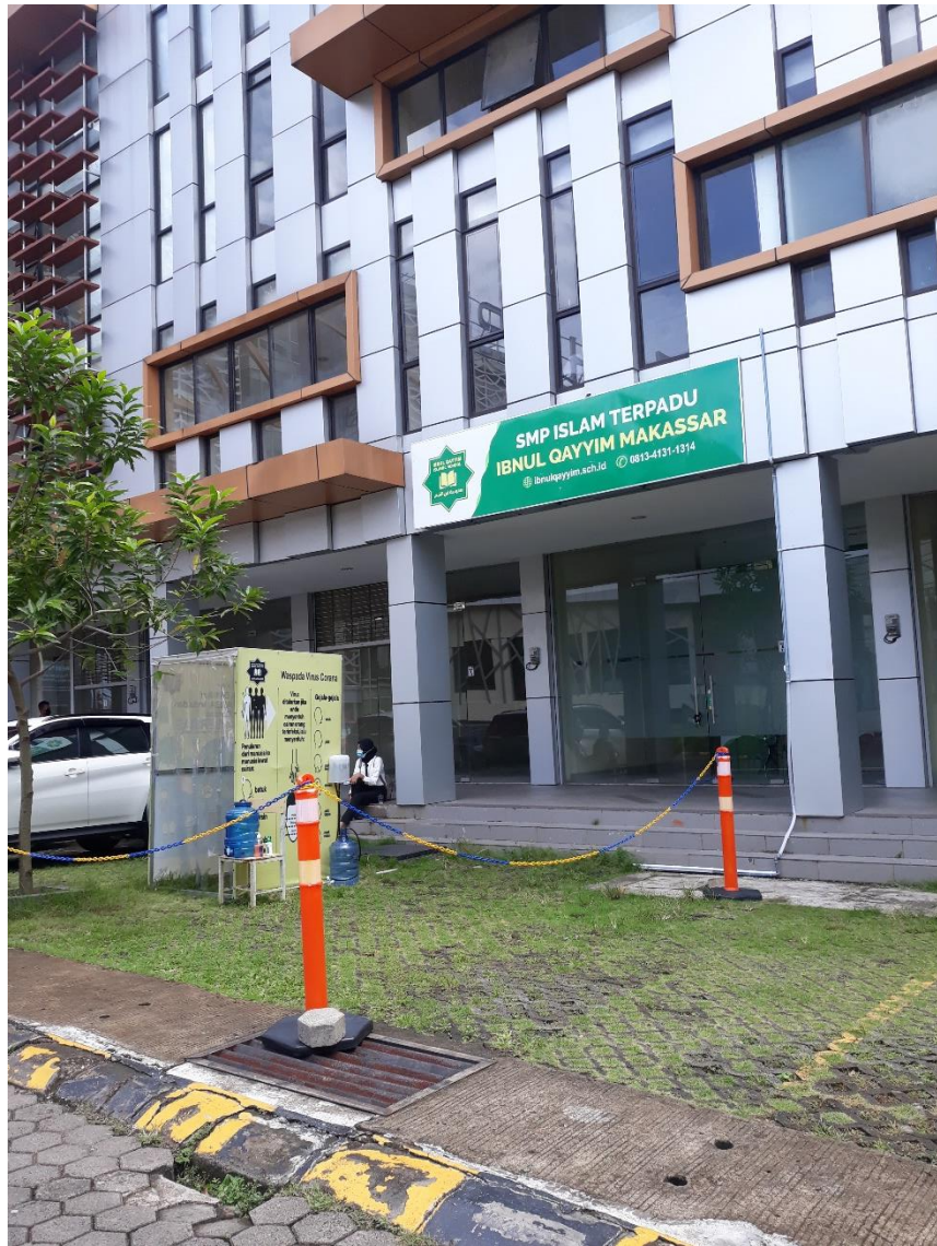
Foto 1 Tampak Depan Bangunan SMPIT Ibnuul Qayyim Makassar
