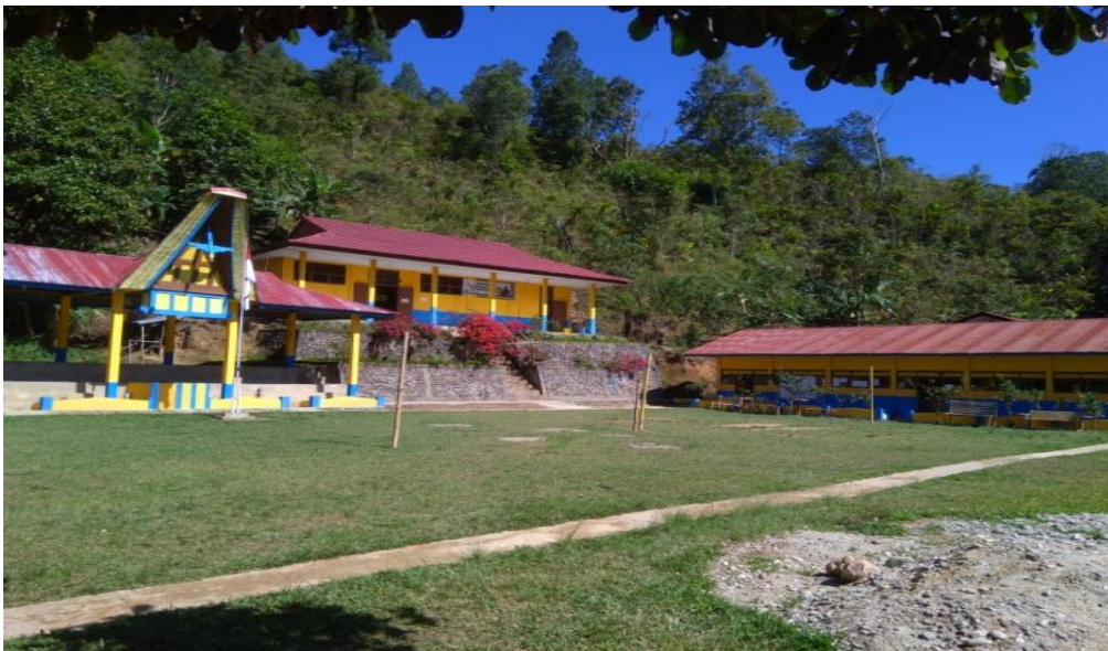
Gedung sekolah SMA Katolik Messawa
