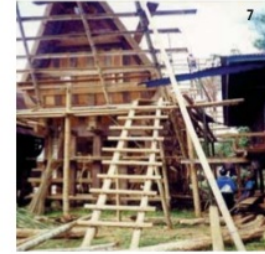
7. Létra készítése az állványokhoz
